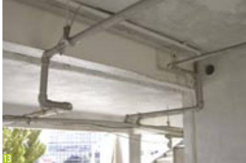
13 ■写真13 剥き出しのパイプ ■写真14 支柱
