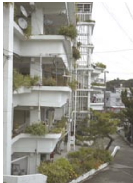
■写真6 ベランダ代わりの通路
